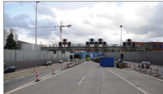
Bild: Südrampe 1.-3. Röhre Elbtunnel (Bundesautobahn
