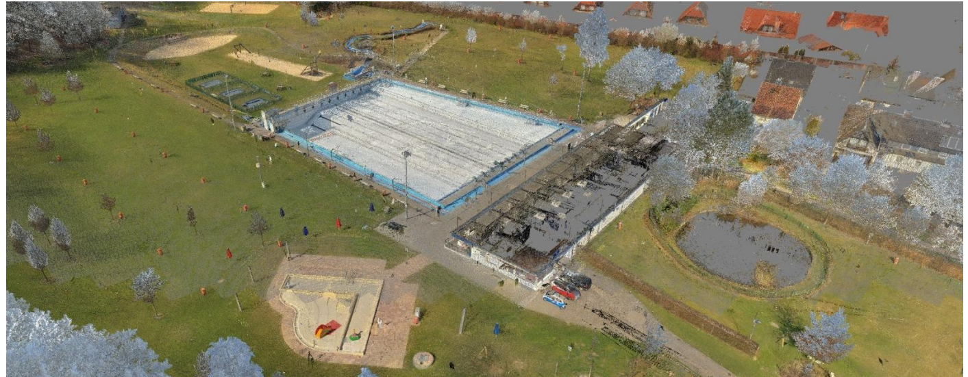
Abb. 1: Ansicht der verknüpften Punktwolken aus terrestrischem 3D Laserscanning in Echtfarbe
